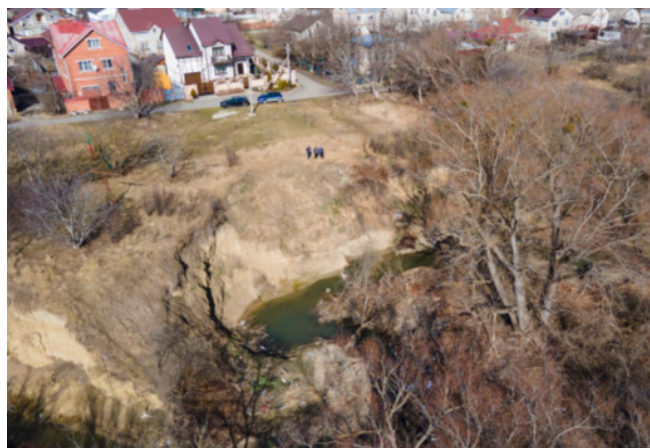
Рис. 1. Оползень из-за смещения русла реки Ташла
