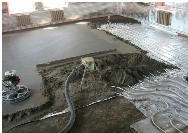
Рис. 1. Механизированная стяжка по теплому полу [2].
