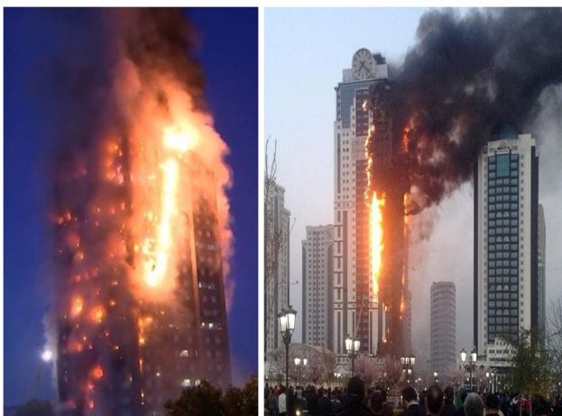
Рисунок 1, 2. Фотофиксация типового пожара в высотном здании.
