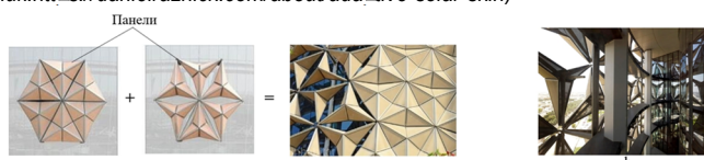
Рис. 3. Динамическая солнцезащита для зданий Аль-Бахар а) Вид на элементы солнцезащиты снаружи; б) Вид на элементы солнцезащиты изнутри (Источник: http://en.uaezoom.com/al-bahar-towers-in-abudhabi )
